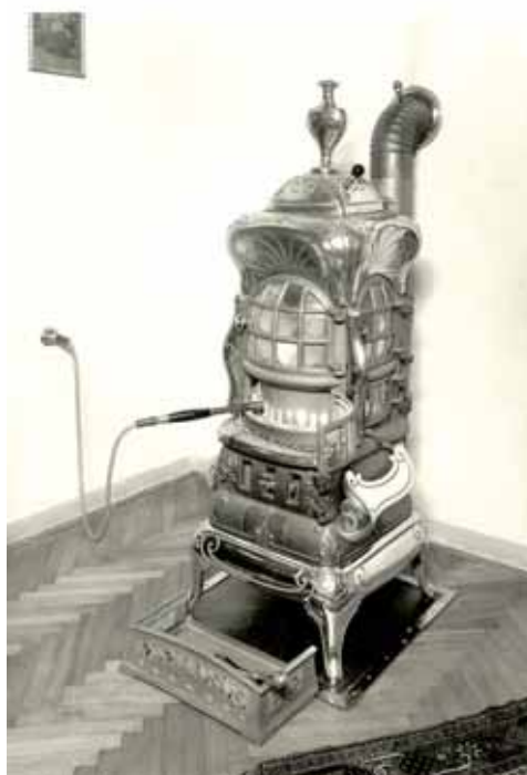
Ukázka z publikace „Plynové spotřebiče v běhu času“ - zapalování koxu v amerických kamnech plynovým zapalovačem
