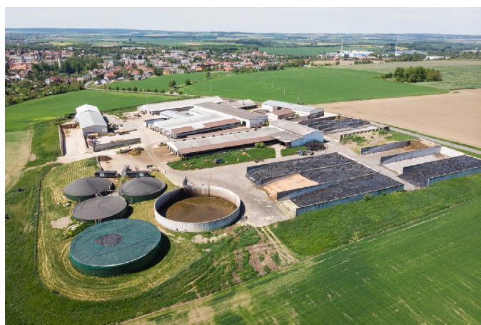
Obr. 25 Bioplynová stanice Litomyšl připojena k distribuční soustavě, kruhové fermentory
